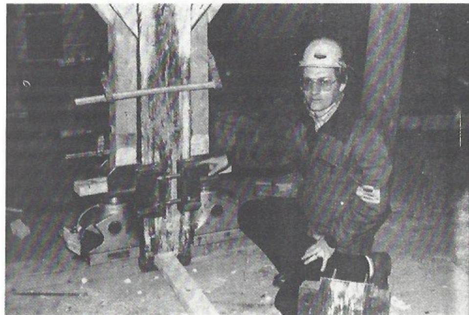
Övre bilden visar hur de rötskadade bjälklagen reparerades. Undre hur avvägningen av bjälklagen gjordes.
